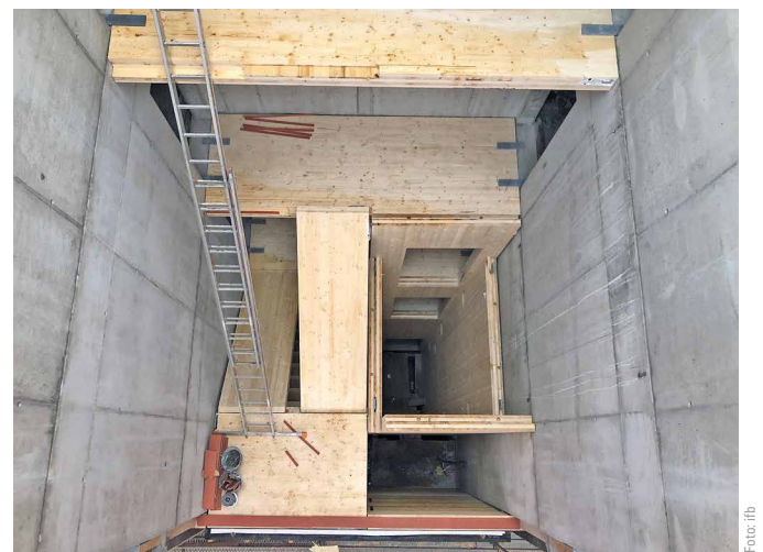
Bild 8 Blick in Treppenhaus und Aufzugsschacht von oben
