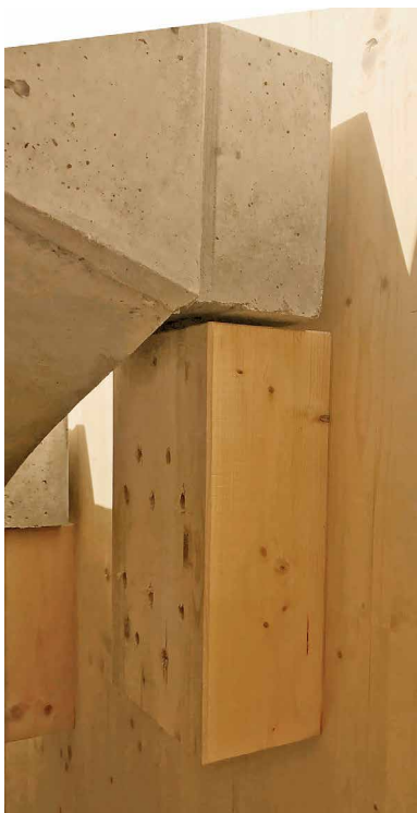
Bild 13 Treppenaufleger in den Maisonetten
