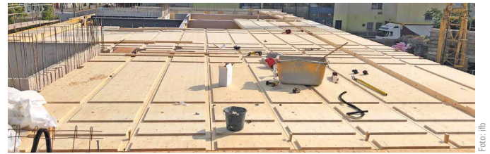
Bild 7 Brettstapeldecke mit Schubkerven
