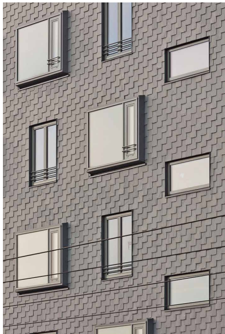
Bild 3 Schuppenpanzer Detail Straßenfassade
